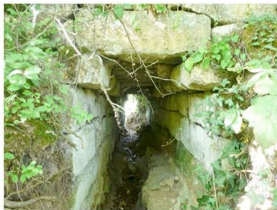
007-Ouvrage d'Art Etang de Gouline.jpg
